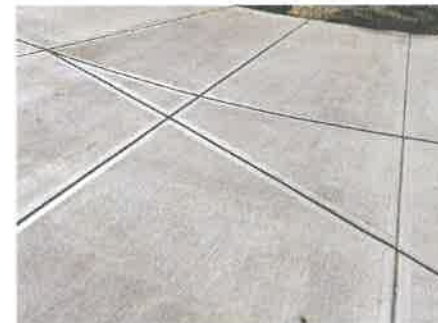
Izgled "češljanog" betona
