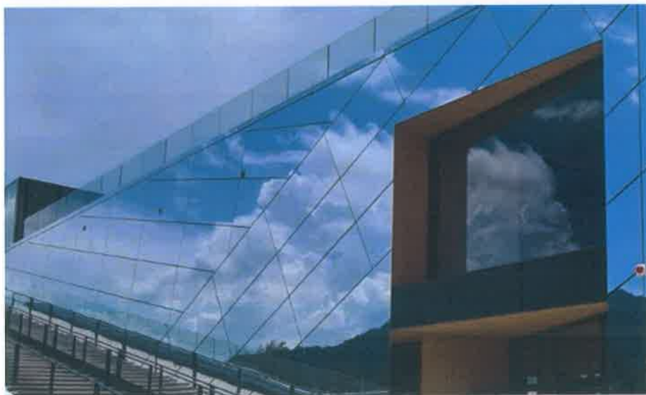
Slika 4. Vanjski izgled zgrade
