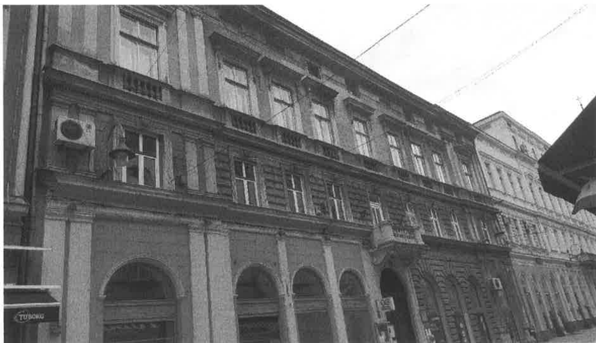
Fotografija prije sanacije i restauracije fasade u ulici Štrosmajerova br. 1 u Sarajevu
