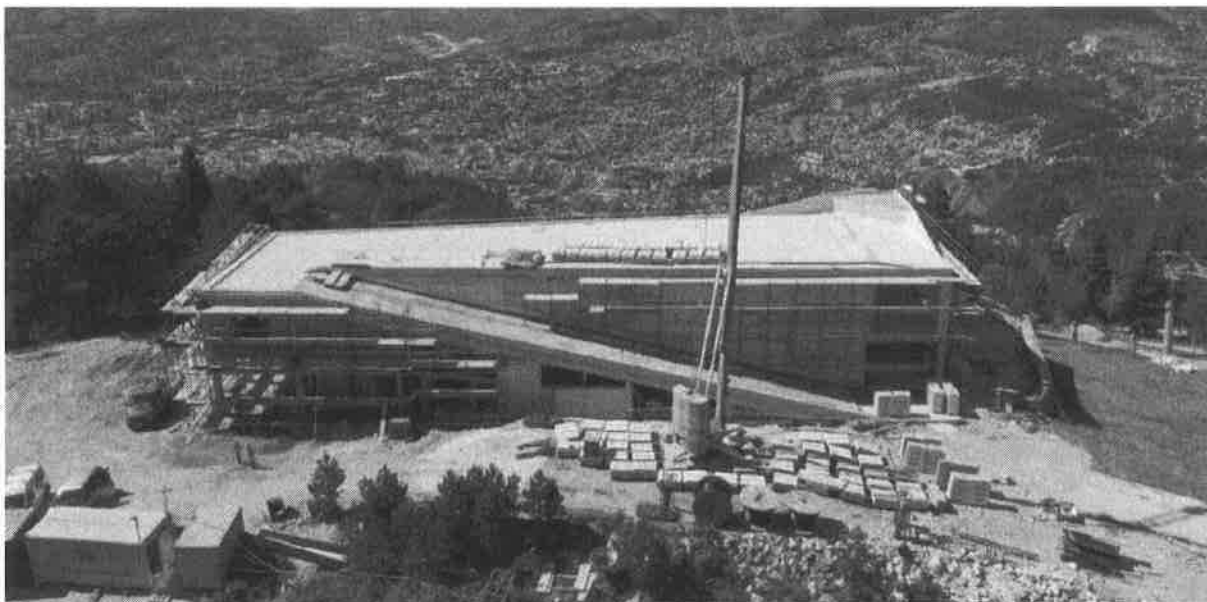
Slika 13. Trenutni stepen izgrađenosti objekta
