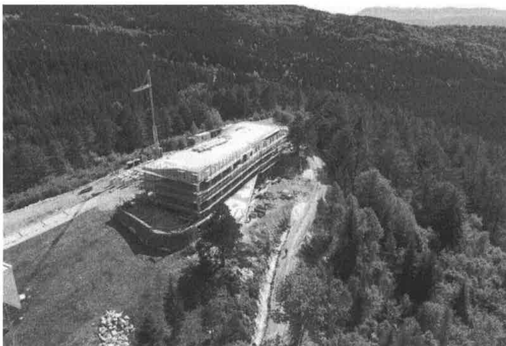
Slika 14. Trenutni stepen izgrađenosti objekta
