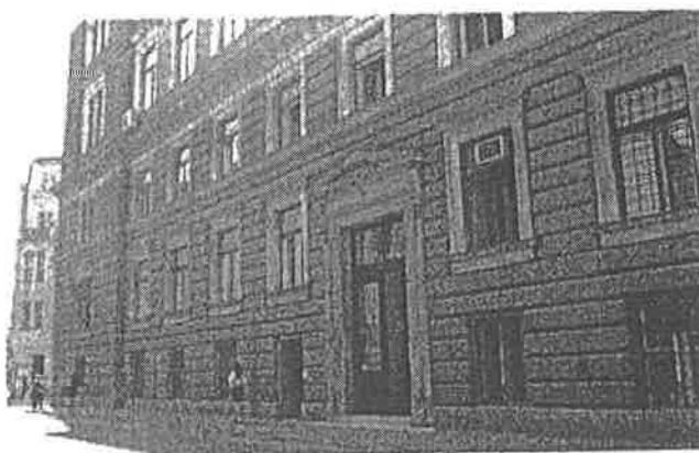
| Zgrada Kantonalnog suda, Branilaca Sarajeva 8
