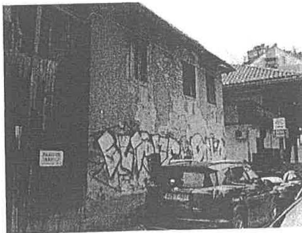
Napušteni objekat na uglu ulica Tabaci i Bravadžiluk mali |
