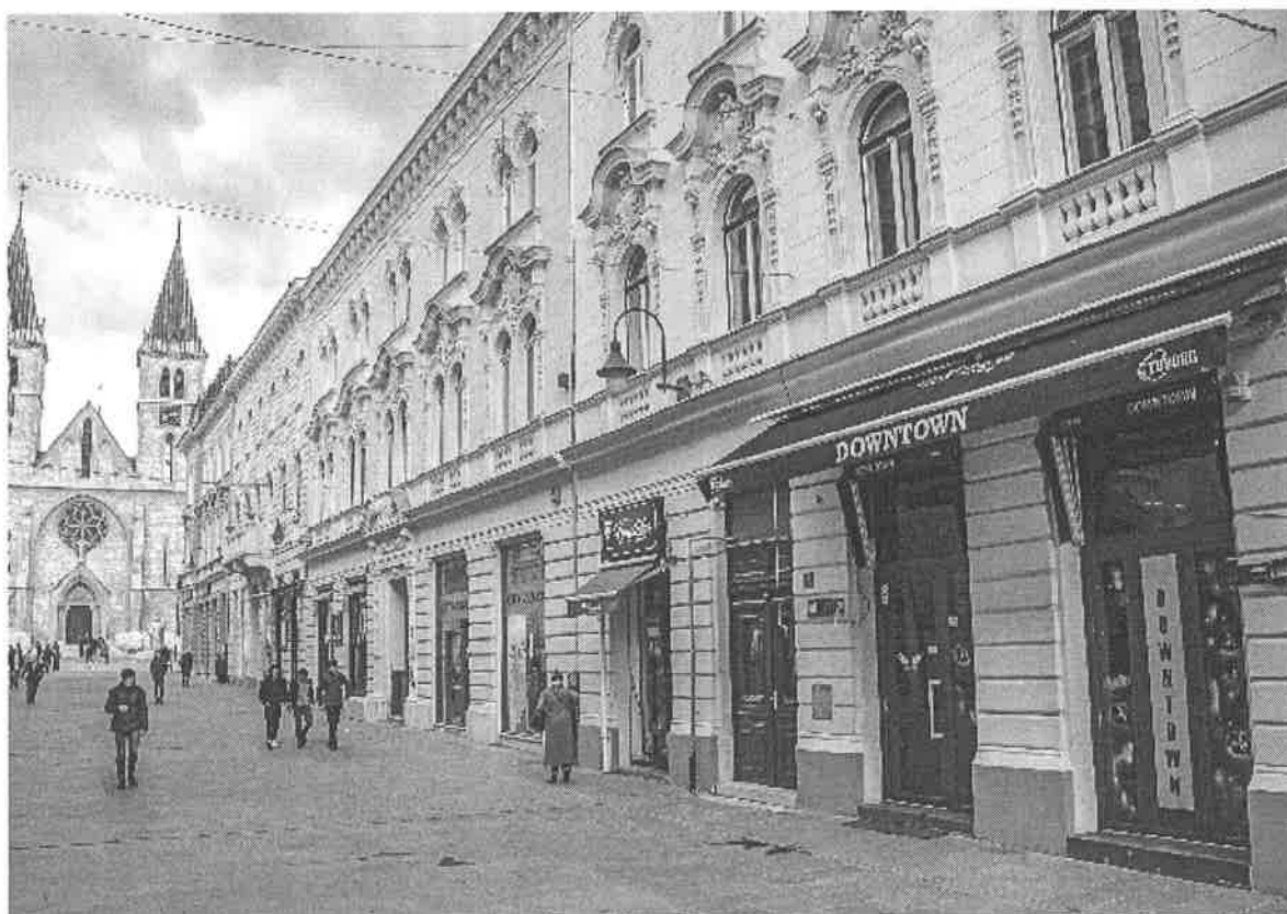
Fotografije nakon sanacije i restauracije fasada u ulici Štrosmajerova br. 4, 6 i 8 u Sarajevu.
