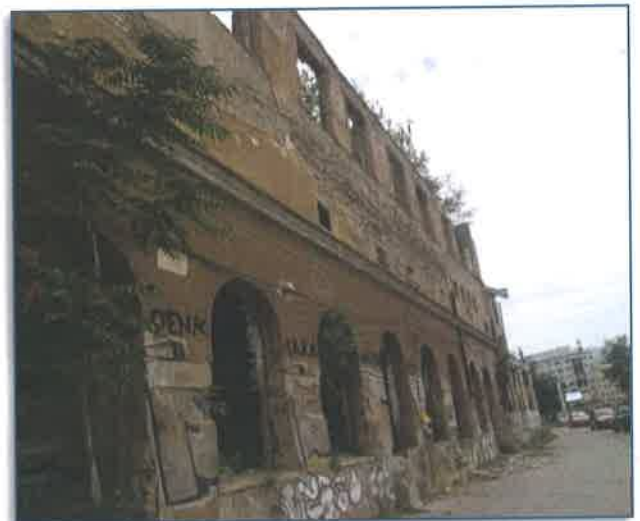
Objekat prve električne centrale, Sarajevo
