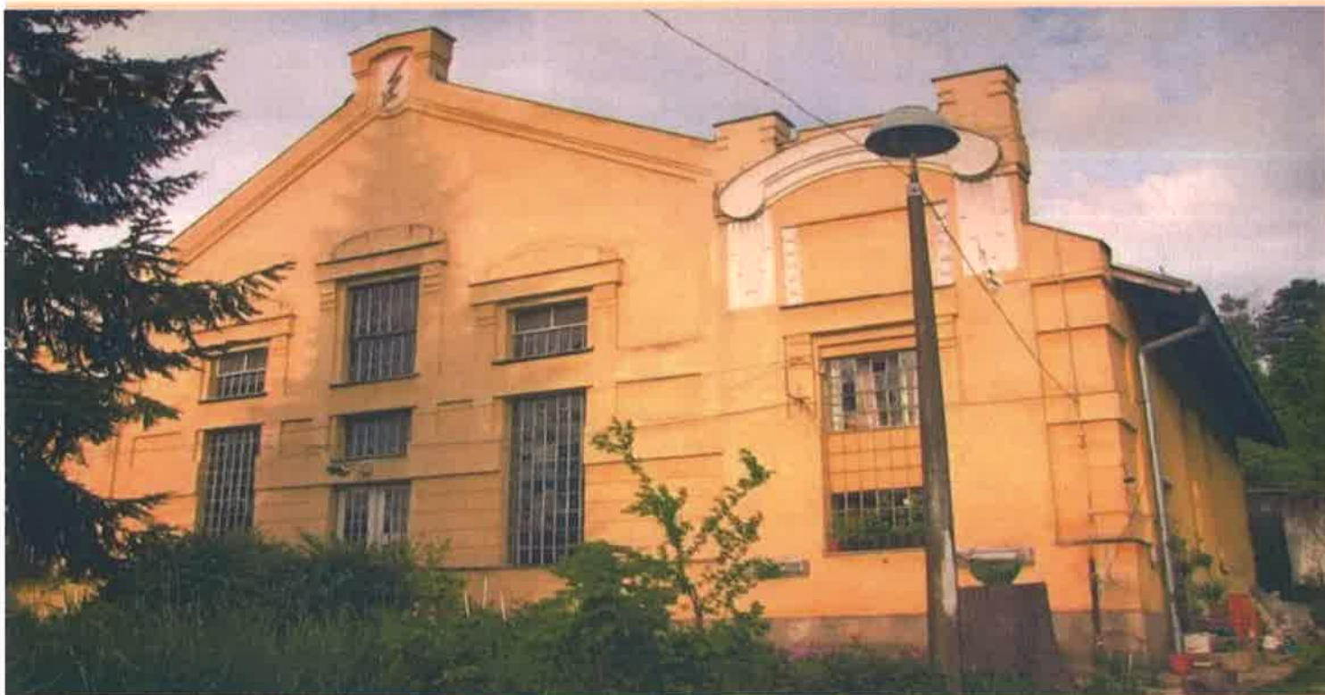
Slika izgleda mašinske zgrade male hidroelektrane Hrid
