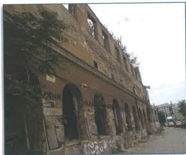
Objekat prve električne centrale, Sarajevo
