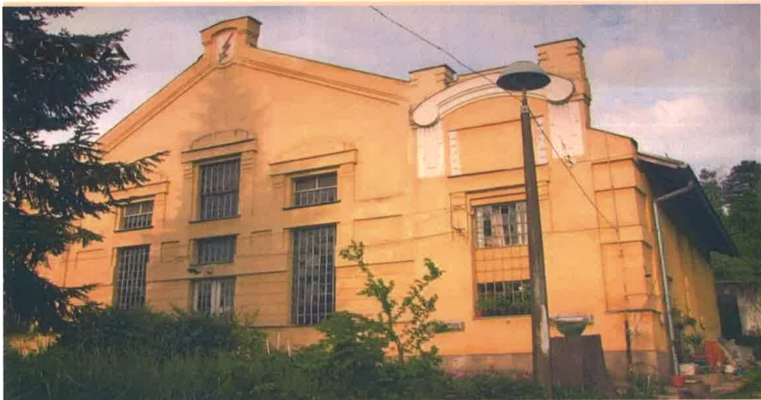
Slika izgleda mašinske zgrade male hidroelektrane Hrid
